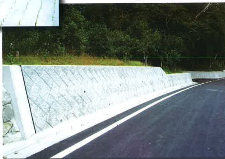
宍粟市 道路改良工事
